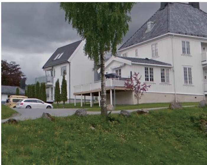
大阳台下面可以通行→可通行建筑
